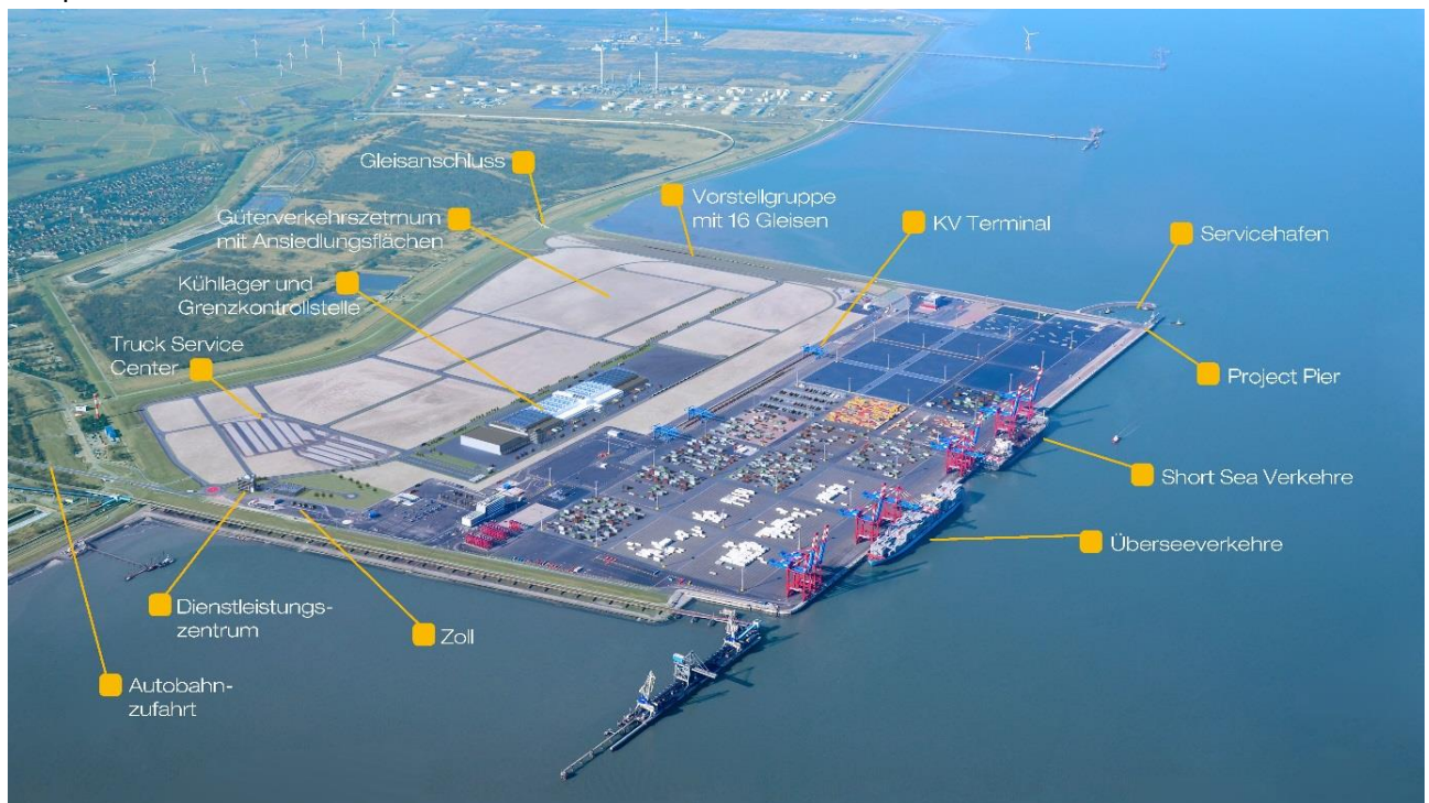
© Container Terminal Wilhelmshaven JadeWeserPort-Marketing GmbH & Co. KG
